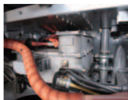
PCU (パワーコントロールユニット)
